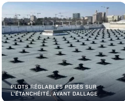
MEMBRANE ARDOISÉE ET RELEVÉS EN TÊTE D'ACROTÈRE
